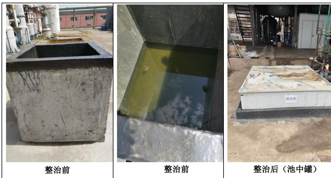
3、污水站芬顿反应池加盖后，废气引入污水处理站废气处理装置处理后外排。
